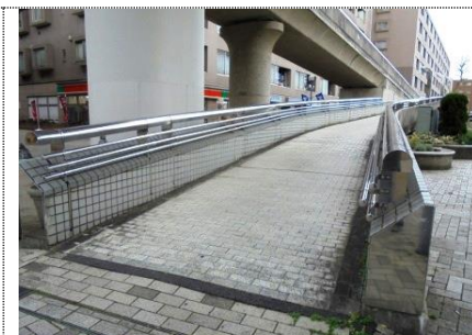
駅前歩道橋のスロープは長く、勾配がきつい車いすは大変
