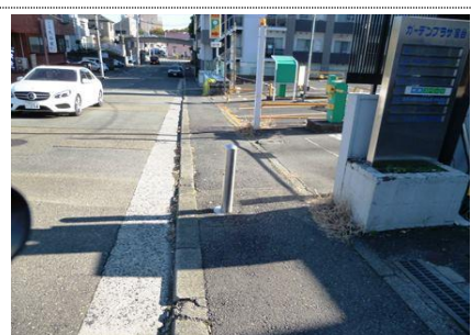
歩道にポールがあったり、駐車入口勾配部では車いすが傾き危険。
