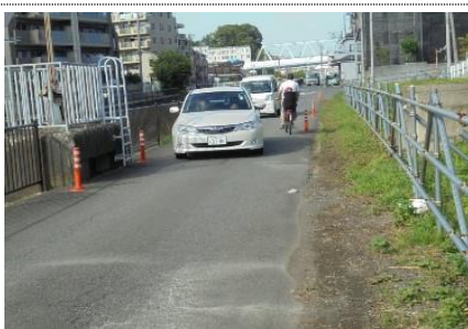
中川3丁目の早淵川沿いの道は狭く、車と自転車、人が交錯して危険
