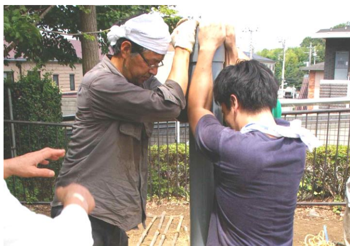
パイプを穴に入れます
