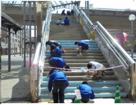
養生をして作業開始
