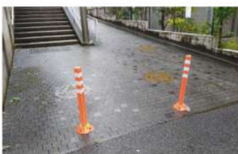
歩行者安全ボールの設置
