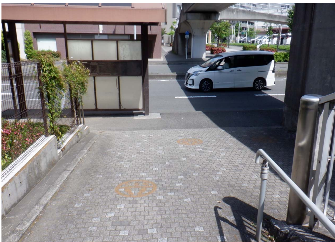
烏山歩道橋全対策施工前
