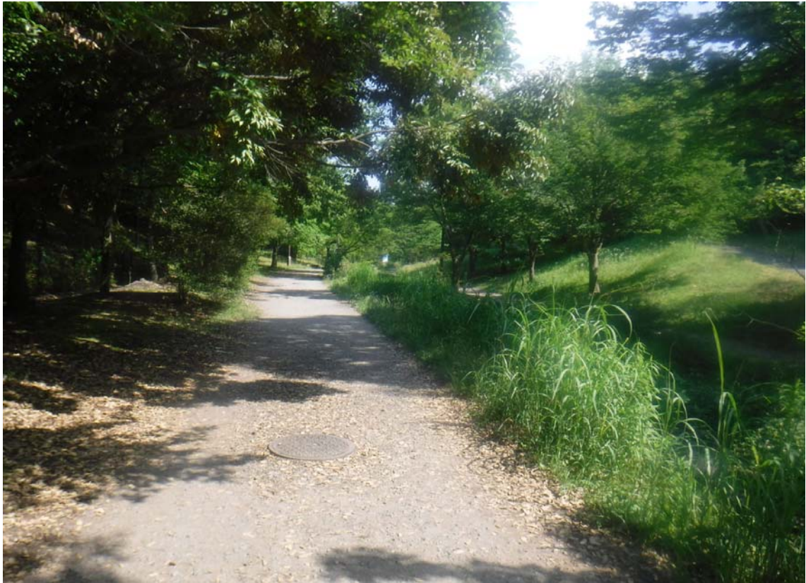
くさぶえのみち園路段差解消前
