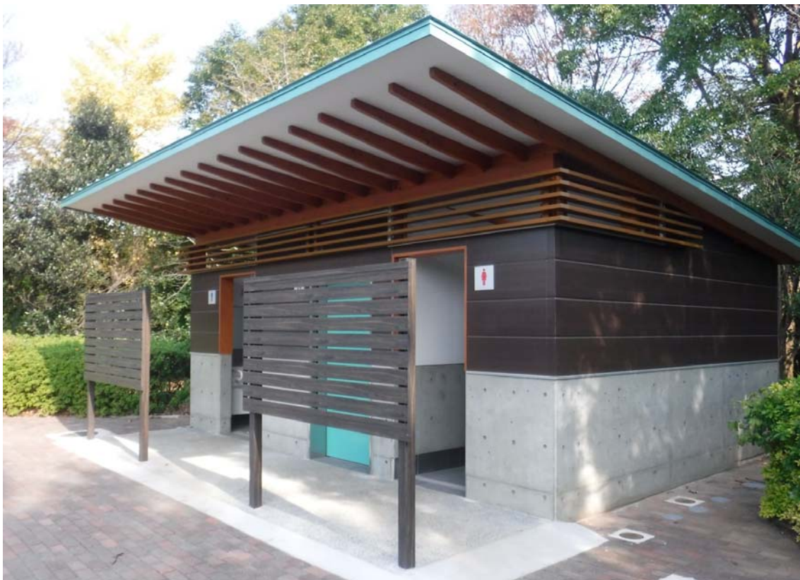
牛久保西公園トイレ施工後
