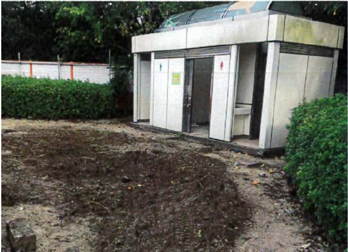
牛久保西公園トイレ施工前
