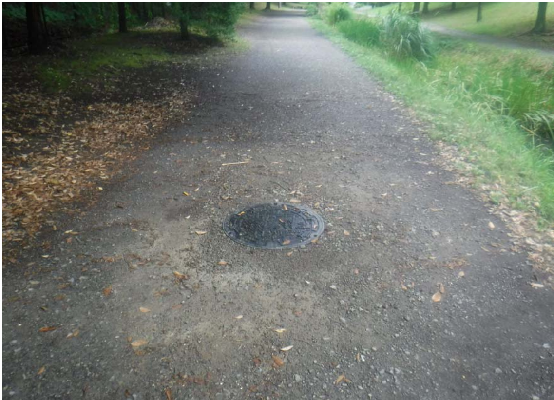
くさぶえのみち園路段差解消後
