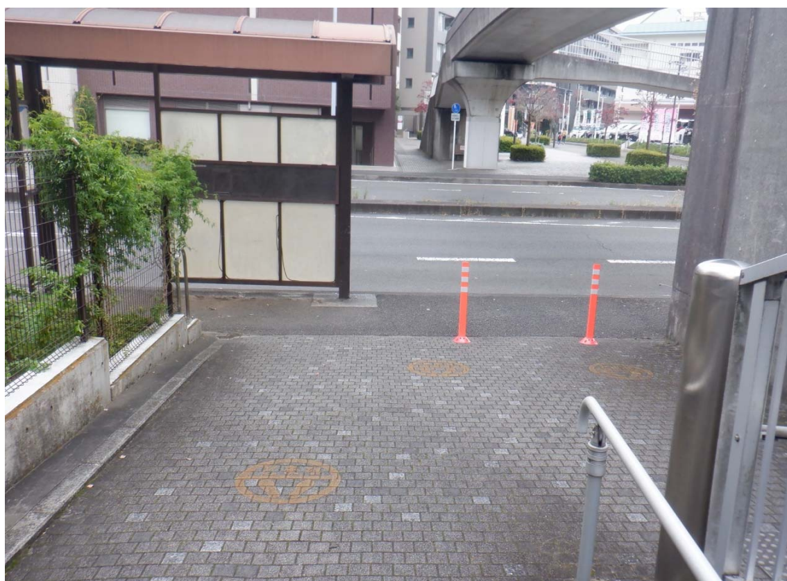
烏山歩道橋安全対策施工後
