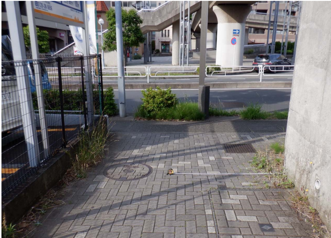
中川歩道橋安全対策施工予定
