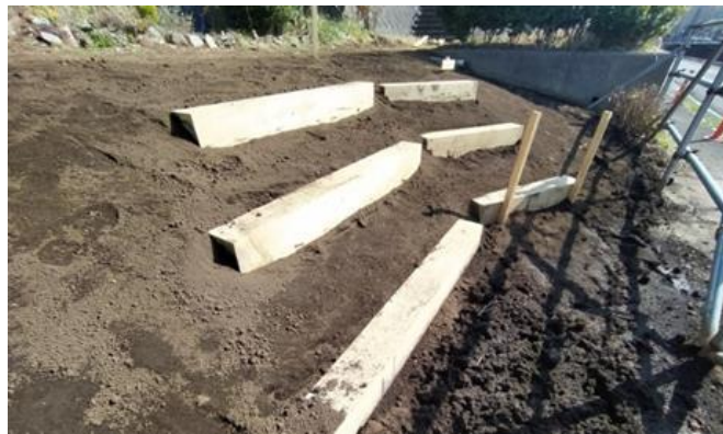
植栽直前の様子 道路沿いが湿っています。
