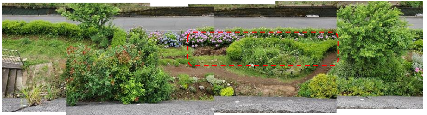
施行前の現場。上が早淵川。下が擁壁。左が擁壁上からの階段。赤枠内が対象地、
